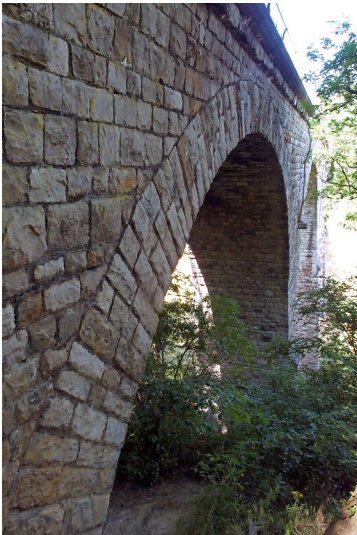
Rollefbach-Viadukt bei Aachen (2022) Fotograf/Urheber: Karl Peter Wiemer
