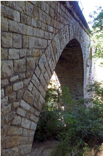
Rollefbach-Viadukt bei Aachen (2022) Fotograf/Urheber: Karl Peter Wiemer
