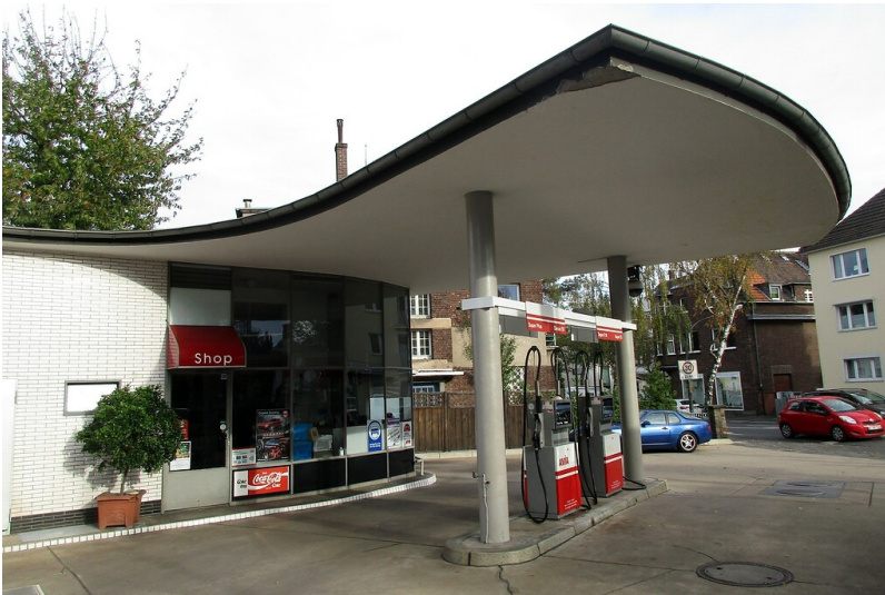
AVIA-Tankstelle in Köln-Rodenkirchen (2022): Über den Zapfsäulen ein für die Nachkriegszeit typisches Spannbeton-Dach, das von zwei Säulen getragen wird, dahinter das kleine Kassenhäuschen. Fotograf/Urheber: Franz-Josef Knöchel
