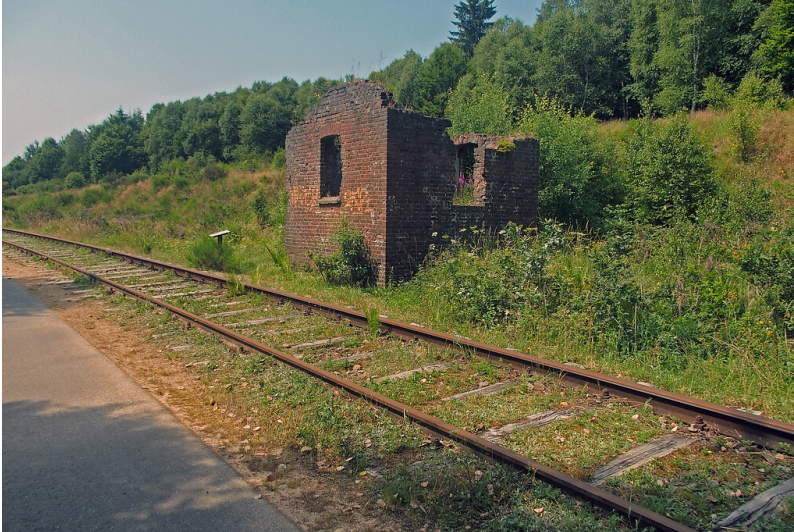
Wachgebäude "Posten PD25bis" an der Vennbahn bei Sourbrodt (2022) Fotograf/Urheber: Karl Peter Wiemer
