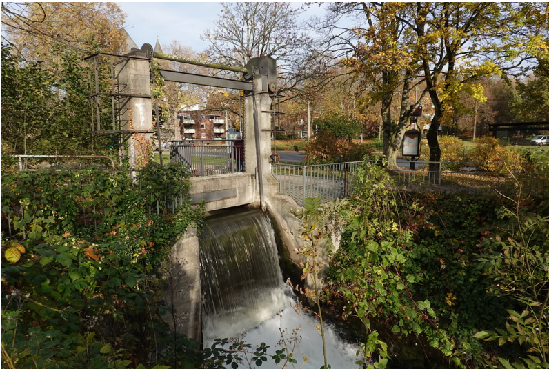
Wehr am Obertor des Erftmühlengrabens (2021) Fotograf/Urheber: Helmut Friedrichs
