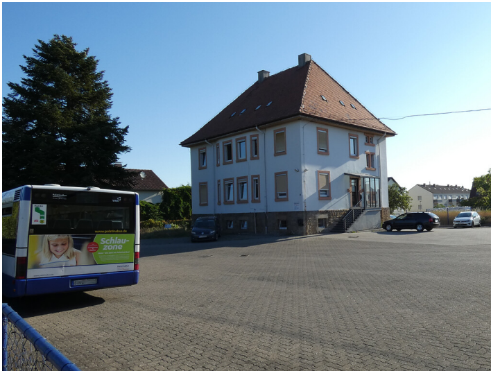
Depot der ehemaligen Pfälzischen Oberlandbahn Fotograf/Urheber: Christine Brehm
