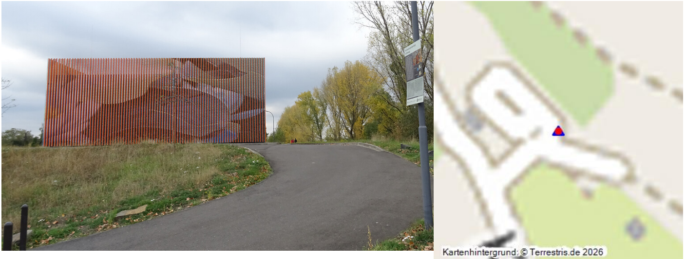
Abb. 1: Erzählstation "Pumpstation Kuhlenweg" mit Informationstafel der StEB Köln am Wassererlebnispfad von Pulheim zum Rhein (2018) Fotograf/Urheber: Reinhard Zeese
