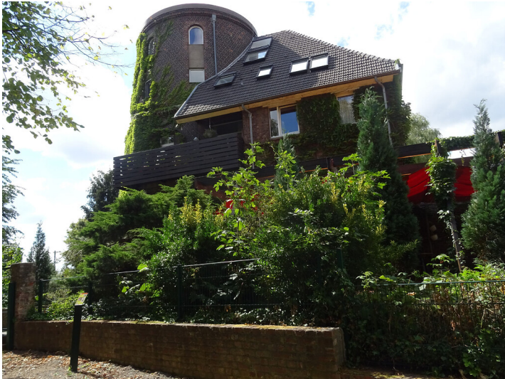
Abb. 1: Erzählstation Wasserturm am Wassererlebnispfad von Pulheim zum Rhein (2018) Fotograf/Urheber: Reinhard Zeese
