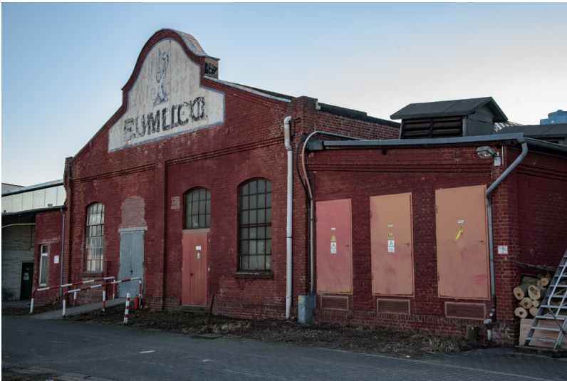
Eumuco Kraftwerk (2021) Fotograf/Urheber: Willy Borgfeldt
