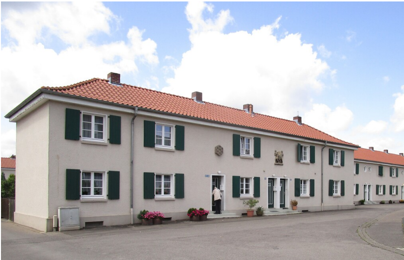
Hauszeile Siedlung Heidehöhe (2021) Fotograf/Urheber: Alexander Kierdorf
