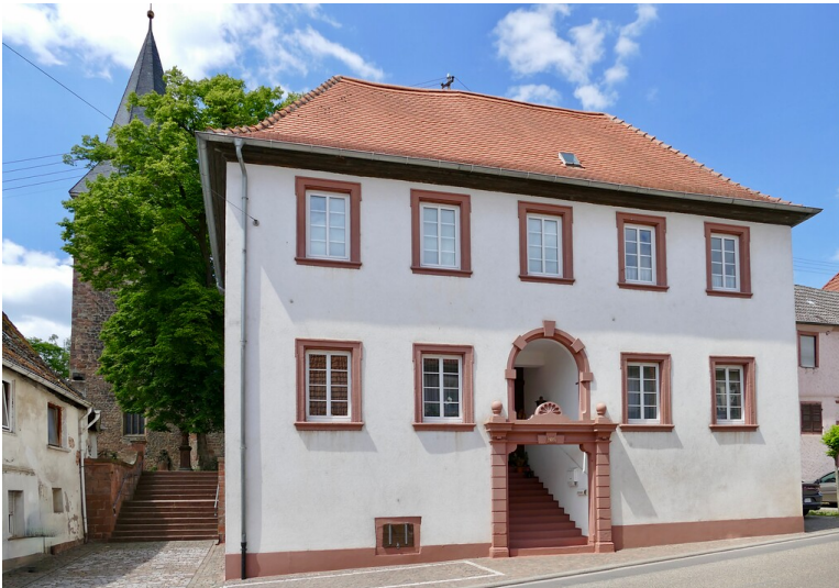
Auf diesem Bild sieht man das Alte Rathaus in Kirrweiler (Pfalz) von der Marktstraße aus (2021) Fotograf/Urheber: Rüdiger Sehr
