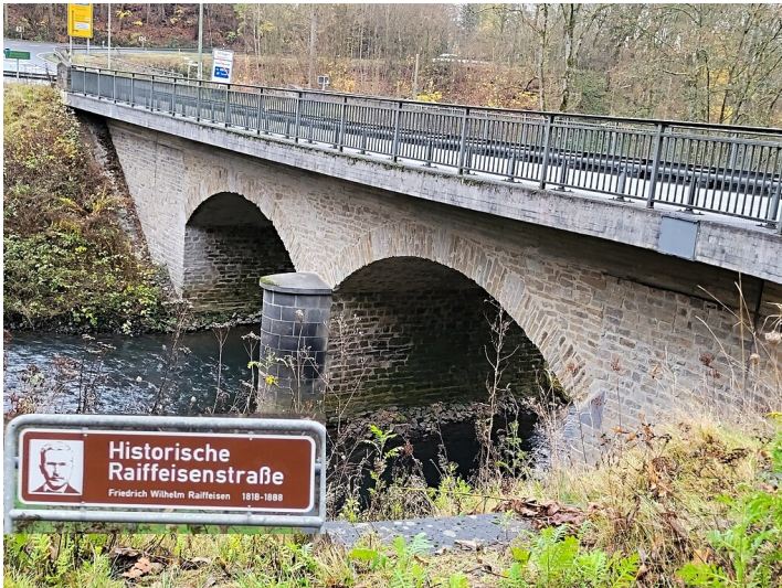
Die Brücke über die Wied zwischen den beiden Ortsgemeinden Eichen und Bürdenbach-Bruchermühle (2021) Fotograf/Urheber: Martina Beer
