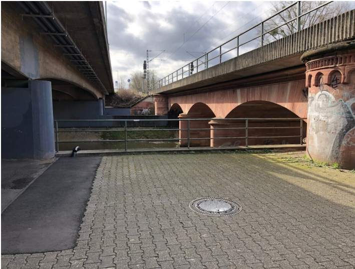
Die Straßenbrücke Kasseler Straße in Bad Vilbel (2020) Fotograf/Urheber: Michael Falk
