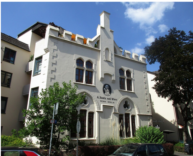
Die noch erhaltene Fassade der einstigen Kaffeerösterei Zuntz ("A. Zuntz sel. Wwe.") mit dem Firmenlogo der "Dame mit dem Schutenhut" in der Königstraße in der Bonner Südstadt (2022). Fotograf/Urheber: Franz-Josef Knöchel
