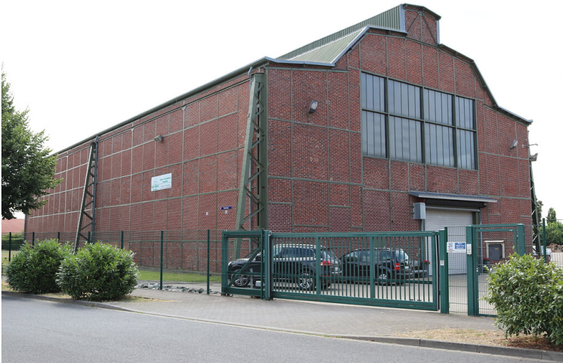
Alte Werkshalle der Grube Carl-Alexander in Baesweiler (2022) Fotograf/Urheber: Robert Gansen
