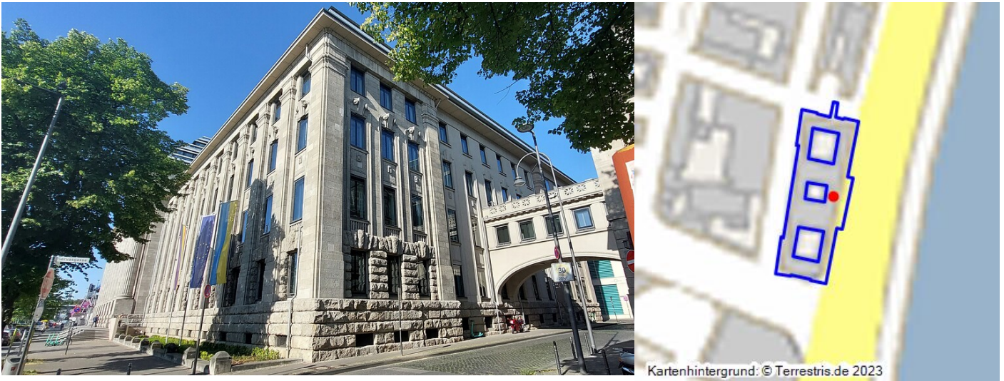
Das frühere Direktionsgebäude der Reichsbahndirektion am Rheinufer in Köln-Altstadt-Nord, rechts im Bild der Brückengang zur benachbarten Direktoren-Villa (2022). Fotograf/Urheber: Franz-Josef Knöchel
