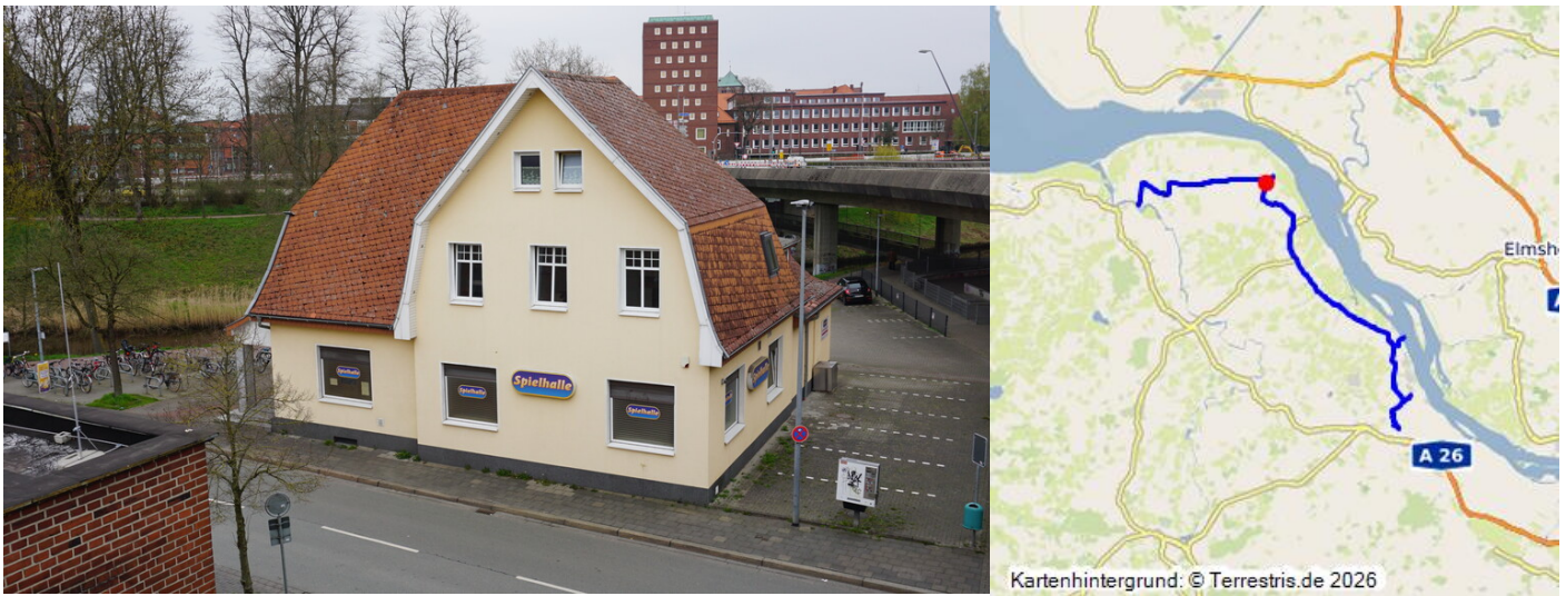
Stade (2023). Bahnhof Kehdinger Kreisbahn, Empfangsgebäude, Straßenseite Fotograf/Urheber: Claus Weber
