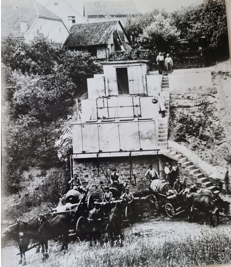
Spritzbrühe-Mischanlage in Laubenheim (ca. 1935) Fotograf/Urheber: Albert Reißner
