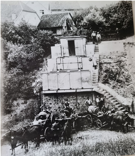
Spritzbrühe-Mischanlage in Laubenheim (ca. 1935) Fotograf/Urheber: Albert Reißner
