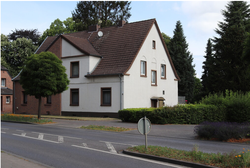
Werkshaus der Grube Carl-Alexander in Baesweiler (2022) Fotograf/Urheber: Robert Gansen
