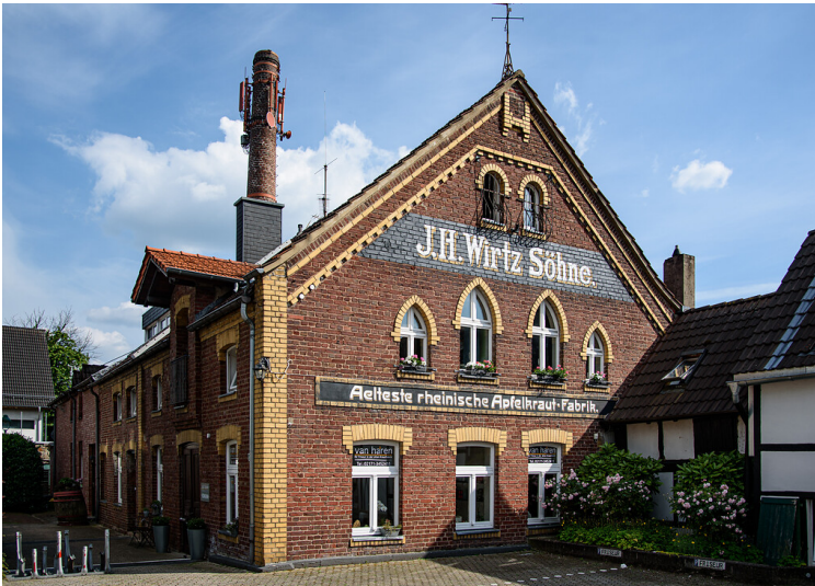
Schrägansicht Rheinische Krautfabrik Bergisch Neukirchen (2021) Fotograf/Urheber: Willy Borgfeldt
