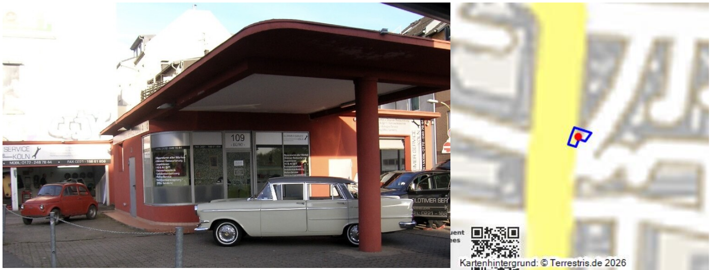
Die zuletzt als Oldtimer-Service genutzte und im Frühjahr 2022 abgerissene historische Tankstelle an der Ecke Frankfurter Straße / Dückergasse in Köln-Buchheim (2017). Fotograf/Urheber: Markus Georgino
