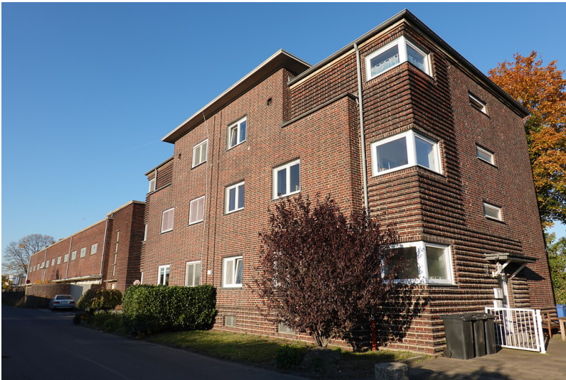
RWE-Umspannanlage im Neusser Hafen (2021) Fotograf/Urheber: Helmut Friedrichs
