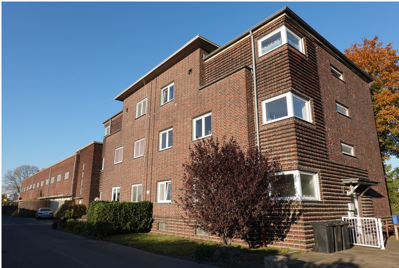
RWE-Umspannanlage im Neusser Hafen (2021) Fotograf/Urheber: Helmut Friedrichs
