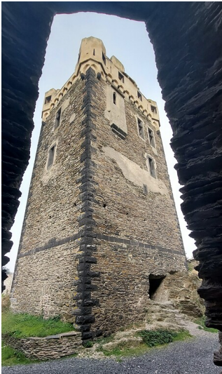
Blick im Inneren der Burgruine Wernerseck von Südwesten auf den mächtigen Wohnturm (2021). Fotograf/Urheber: Franz-Josef Knöchel
