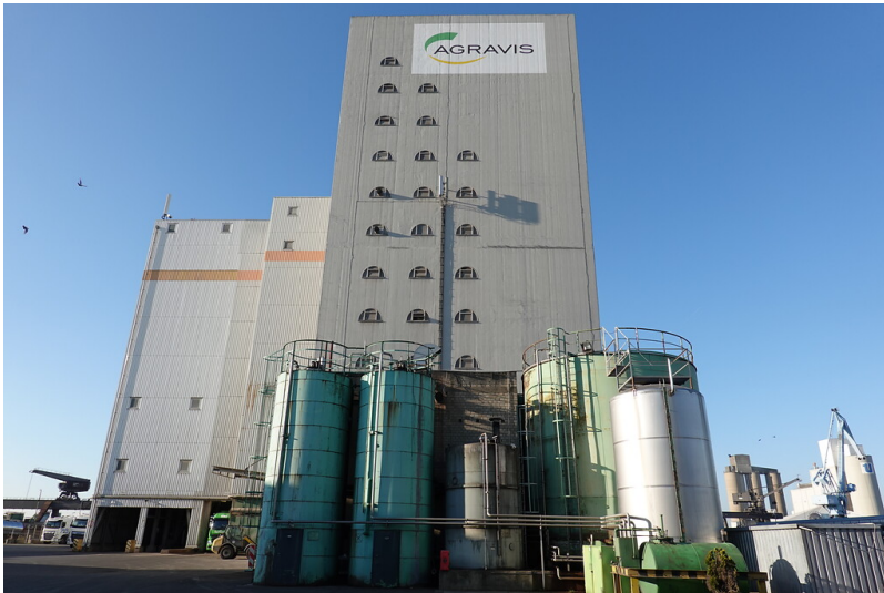
Agravis Kraftfutterwerk Duisburger Straße (2021) Fotograf/Urheber: Helmut Friedrichs
