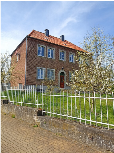
Ehemaliges Pastorat Hackenbroich a (2022) Fotograf/Urheber: Dana Pfeiffer
