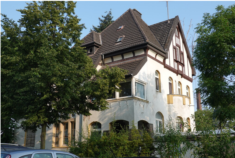
Ehemaliges Wohnhaus des Schlachthofes Neuss (2021) Fotograf/Urheber: Sophie Klems
