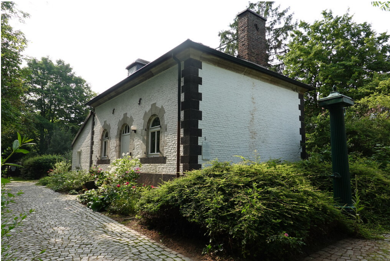
Kanalwärterhäuschen am Nordkanal (2021) Fotograf/Urheber: Helmut Friedrichs
