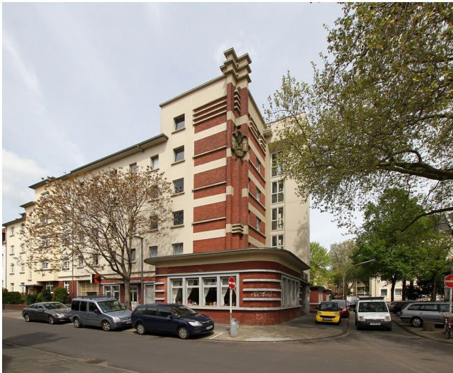
Kolpinghaus in Köln-Mülheim (2012) Fotograf/Urheber: Willy Horsch
