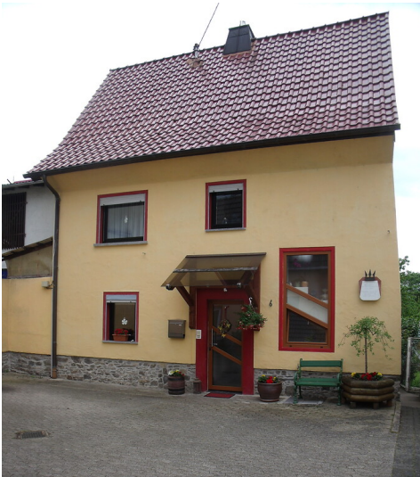
Ehemaliges Jesuitenhofhaus in Koblenz-Lay Fotograf/Urheber: Theisen, Richard
