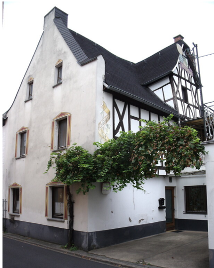
Fachwerkhaus in der Maistraße 8 in Koblenz-Lay Fotograf/Urheber: Theisen, Richard
