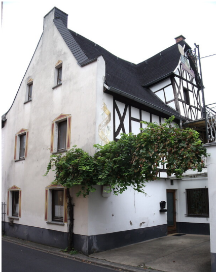
Fachwerkhaus in der Maistraße 8 in Koblenz-Lay Fotograf/Urheber: Theisen, Richard
