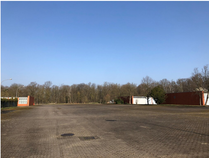
Drei Lagerhallen des ehemaligen Fernmeldenotdienstes in Baal (2022) Fotograf/Urheber: Sophie Klems
