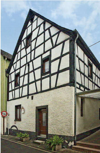
Gebäude der alten Schule in Koblenz-Lay Fotograf/Urheber: Theisen, Richard
