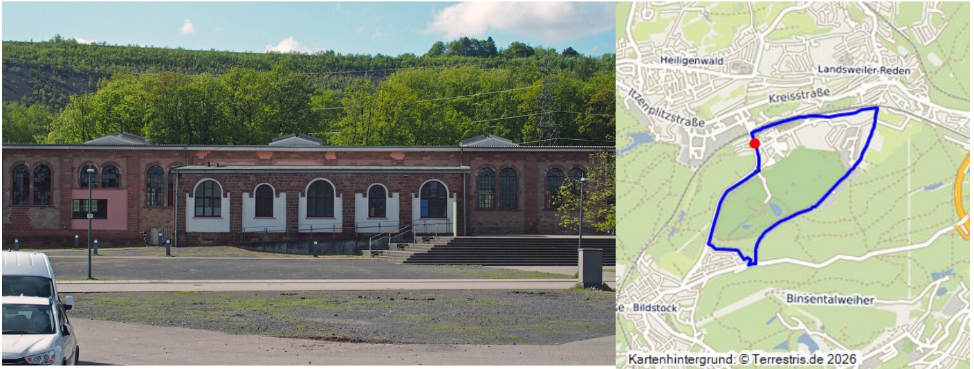
Grube Reden in Schiffweiler (2024) Fotograf/Urheber: Karl Peter Wiemer
