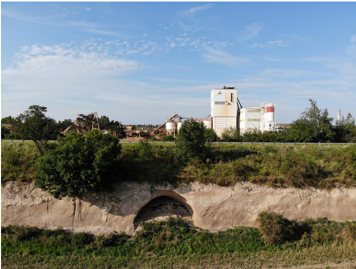
Ehemaliger Stolleneingang im Hang nahe der Bundesstraße 256 im Krufter Bachtal zwischen Kruft und Plaidt (2021) Fotograf/Urheber: Maximilian Kloft
