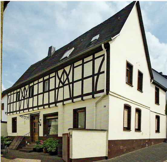
Fachwerkhaus Kaufunger Straße 25, Koblenz-Lay Fotograf/Urheber: Generaldirektion Kulturelles Erbe
