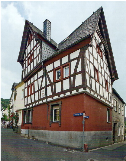
Spätmittelalterliches Fachwerkhaus in der Hirtenstraße 1 in Koblenz-Lay Fotograf/Urheber: Generaldirektion Kulturelles Erbe
