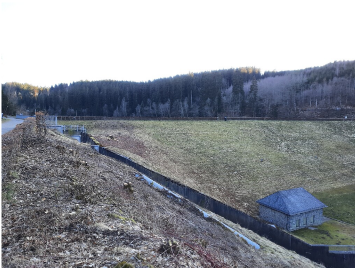
Staudamm der Perlenbachtalsperre (2022) Fotograf/Urheber: Martina Gelhar
