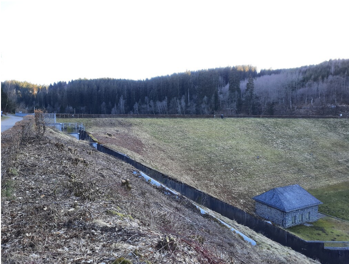
Staudamm der Perlenbachtalsperre (2022) Fotograf/Urheber: Martina Gelhar
