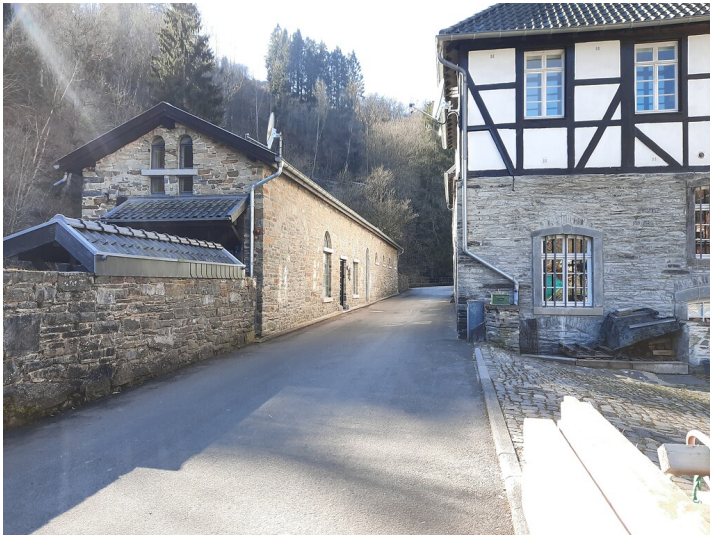
Bruchsteinhaus und Industriegebäude der ehemaligen Tuchfabrik Scheibler (2022) Fotograf/Urheber: Martina Gelhar
