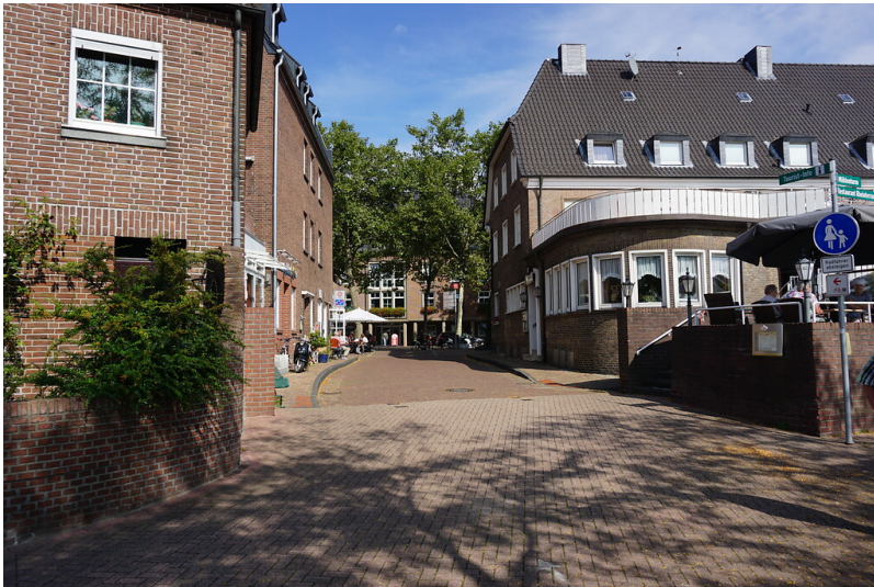
Rees, Rheinpromenade (2021). Wasserstraße, im Hintergrund der Marktplatz mit Rathaus. In Höhe des gerundeten Vorbaus lag das Krantor Fotograf/Urheber: Claus Weber
