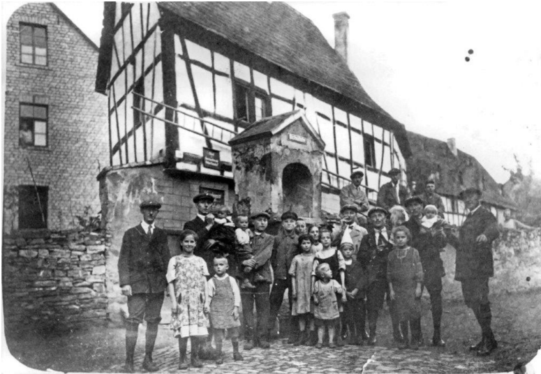
Sieben Fußfälle in Koblenz-Lay Fotograf/Urheber: Peter Flöck
