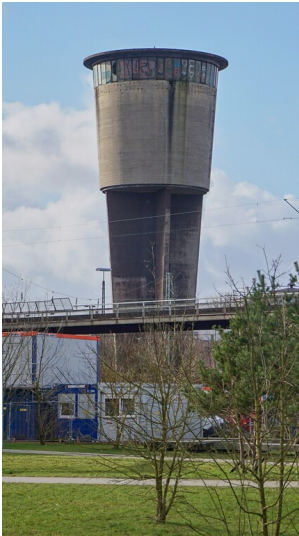
Hamburg-Altona, Wasserturm Betriebswerk Altona (2022) Fotograf/Urheber: Claus Weber
