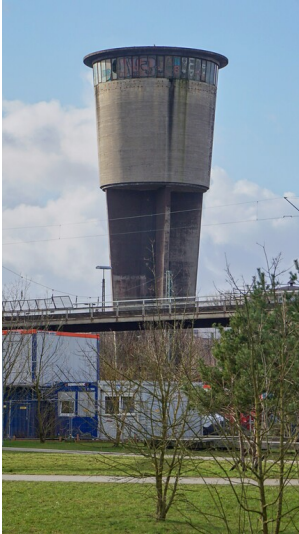
Hamburg-Altona, Wasserturm Betriebswerk Altona (2022) Fotograf/Urheber: Claus Weber
