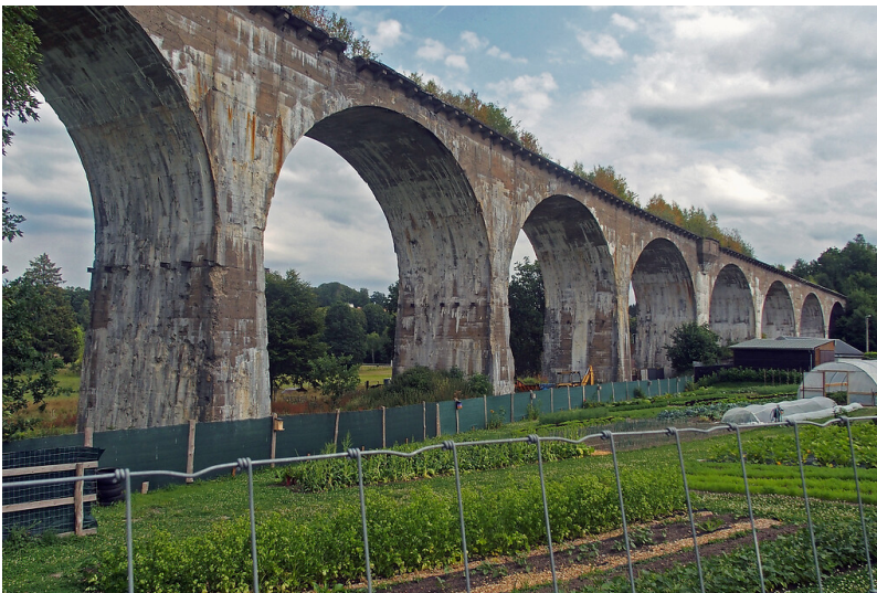
Viadukt von Born (2022) Fotograf/Urheber: Karl Peter Wiemer
