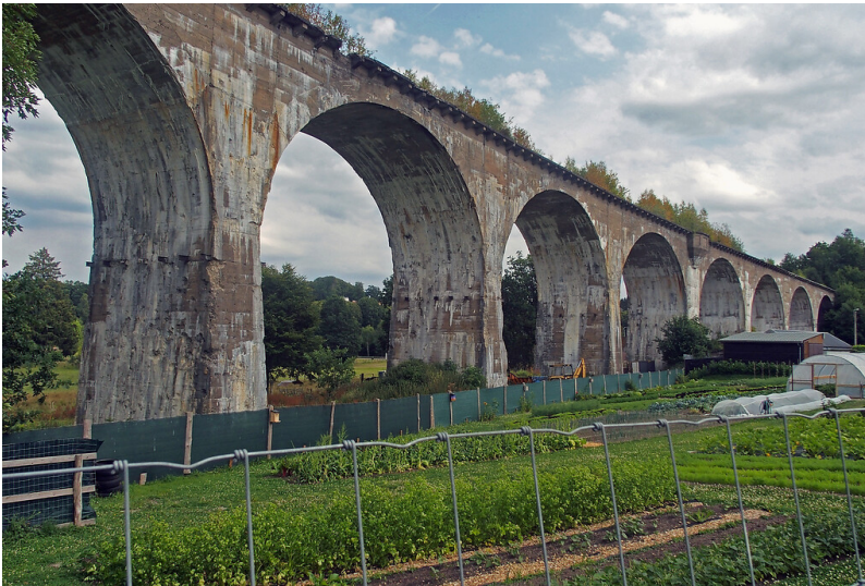
Viadukt von Born (2022) Fotograf/Urheber: Karl Peter Wiemer
