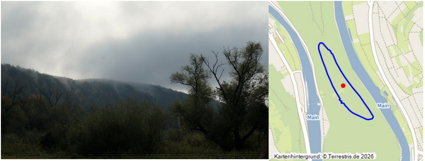
Abschnittsbefestigung „Wettenburg“ bei Kreuzwertheim im Landkreis Main-Spessart, Ansicht von Nordwesten (2019). Fotograf/Urheber: Dirk Vermaaten
