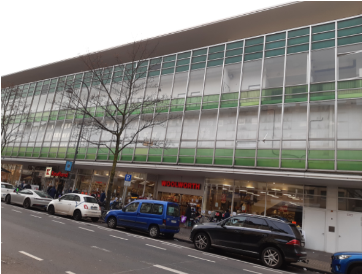
Fassade des ehemaligen Kaufhofs in Köln-Kalk (2021) Fotograf/Urheber: Theresa Steidl
