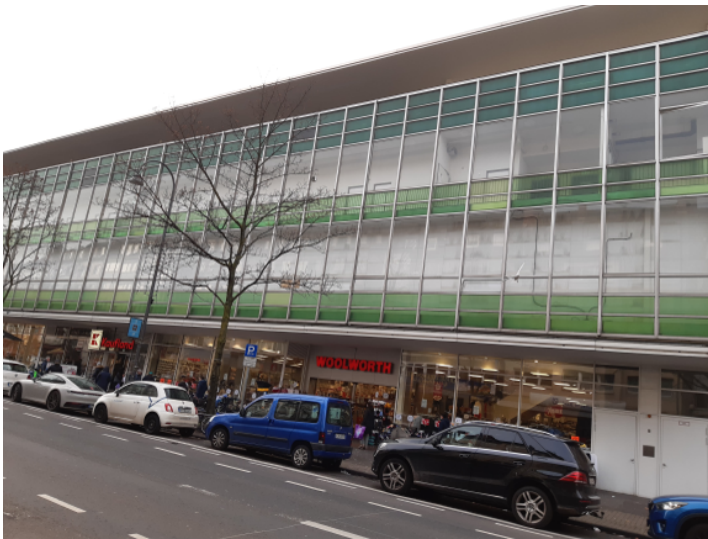
Fassade des ehemaligen Kaufhofs in Köln-Kalk (2021) Fotograf/Urheber: Theresa Steidl
