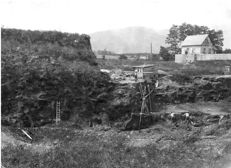
Blick auf die Grube Haans Loch in Plaidt, in der Tuffstein im Tagebau gewonnen wurde (1911) Fotograf/Urheber: unbekannt
