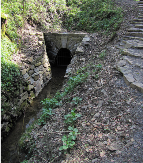
Bodendenkmal Goldener Trog in Wiehl (2011) Fotograf/Urheber: Christoph Weitkemper
