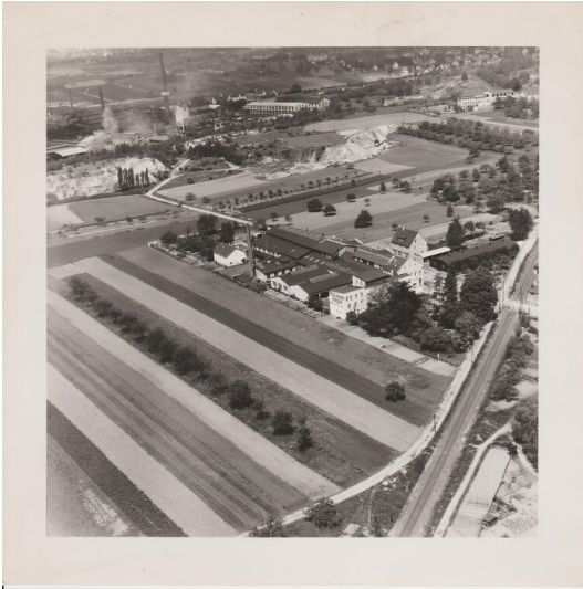
Historische Luftaufnahme der Firmengebäude Feld & Hahn (1950er/1960er Jahre) Fotograf/Urheber: unbekannt
