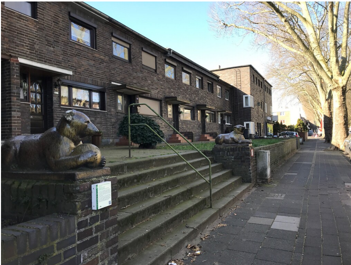
Zwei Bären bewachen die Treppe zur Reihenhauszeile Typ II mit Kopfbauten am Freiheitsring in Frechen (2020) Fotograf/Urheber: Nicole Schmitz
