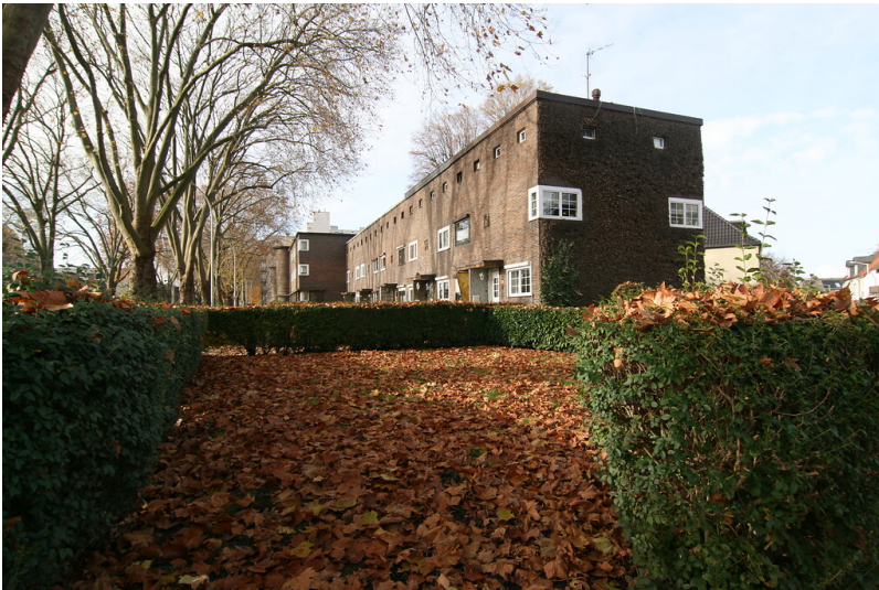
Dreigeschossige Reihenhäuser des Typs III aus Backstein mit Vorgartenbereich am Freiheitsring in Frechen (2021) Fotograf/Urheber: Nicole Schmitz
